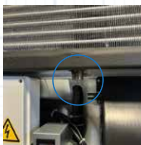
Attacco per lo scarico diretto della condensa
